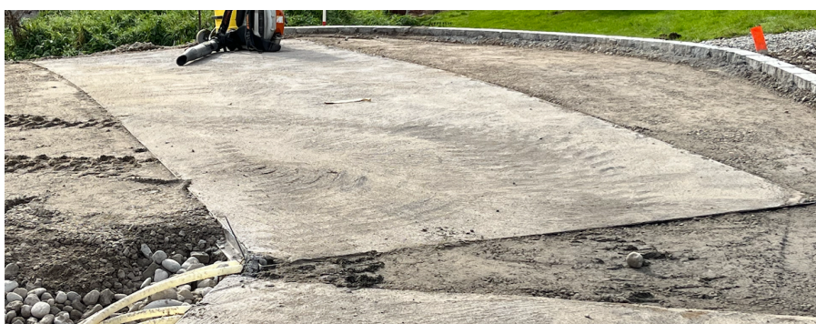
Bild 11: Zur Organisation der weiteren Arbeiten war der Wechsel zur Einlage der Rohre in eine Zementmörtelschicht eine grosse Vereinfachung, können die Felder nun doch nach dem Aushärten sofort mit schwerem Gerät befahren werden.
