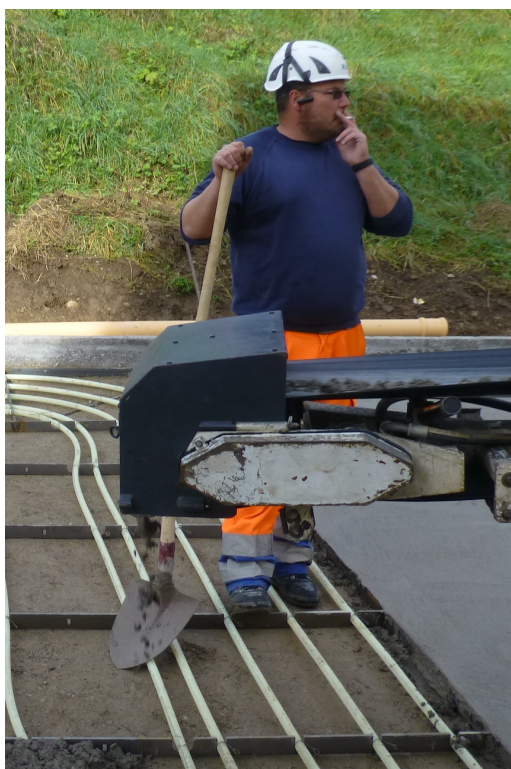
Bild 13: Die Rohre werden wenn möglich nicht belastet. Dank dem Abstand kann das Personal zwischen den Rohren stehen.
