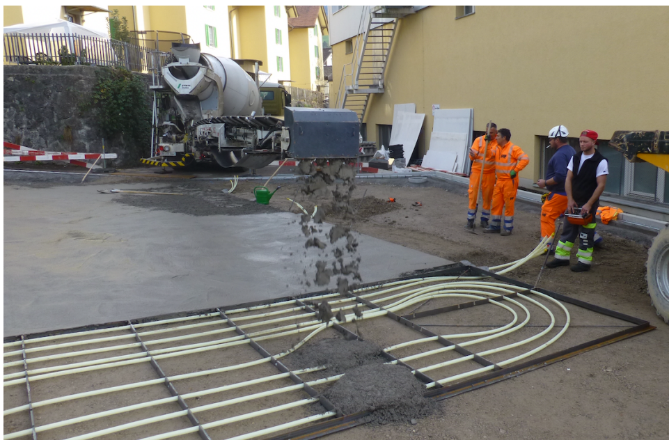
Bild 13: Die Rohre werden wenn möglich nicht belastet. Dank dem Abstand kann das Personal zwischen den Rohren stehen.
