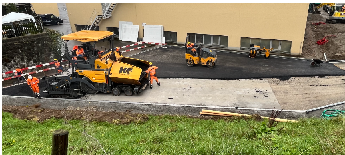
Bild 15: Die Asphaltschicht wird mit einem Strassenfertiger eingebaut.
