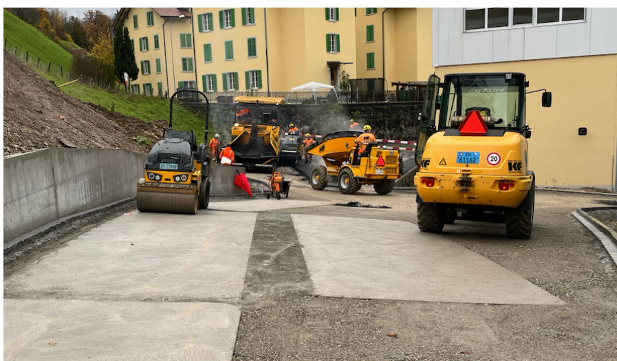
Bild 11: Zur Organisation der weiteren Arbeiten war der Wechsel zur Einlage der Rohre in eine Zementmörtelschicht eine grosse Vereinfachung, können die Felder nun doch nach dem Aushärten sofort mit schwerem Gerät befahren werden.
